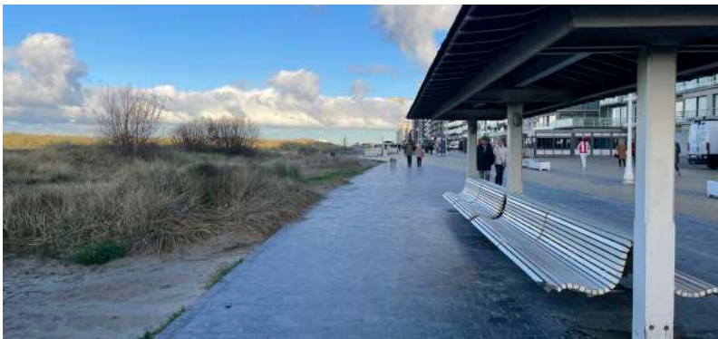
FIGUUR 92: Nieuwpoort - Losstaand afdak zorgt voor geborgen gevoel.
