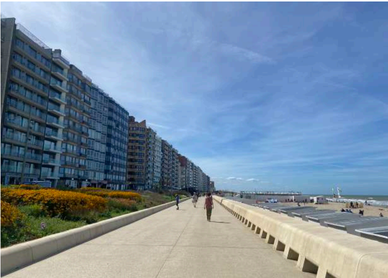
FIGUUR 96: Westende - de vernieuwde zeedijk maakt de overgang tussen zeedijk en strand zachter, door het implementeren van een wandelpromenade en een groenstrook tussen zeedijk en wandelpromenade die het hoogteverschil opvangt.
